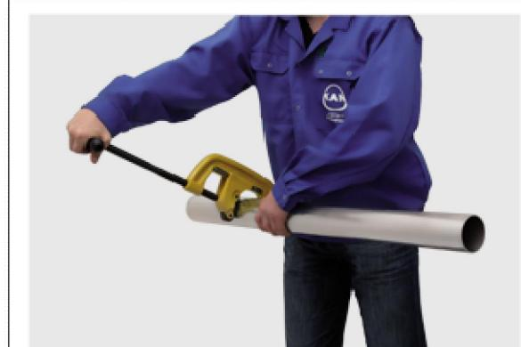
2. Используя ручной или электрический фаскосниматель (для больших диаметров полукруглый напильник для стали), необходимо снять фаску с внутреннего и наружного торца отрезанной трубы, удаляя все зазубрины, которые могут повредить уплотнение O-Ring в процессе монтажа. Также следует удалить опилки, находящиеся на и в трубе, которые могут привести к возникновению точечной коррозии.
